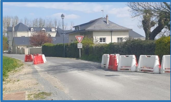
Installation de chicane rue Valbrun en attendant un aménagement définitif.
