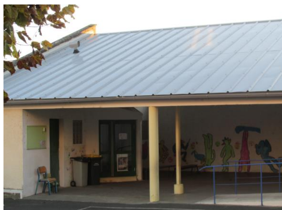
Nouvelle toiture de l'école de Souzay-Champigny
