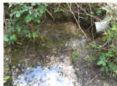
Vidange château d'eau
