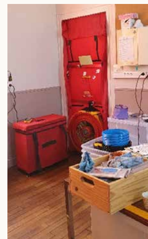
Test des flux d'aération. Classe fermée : les courants d'air sont nombreux !
