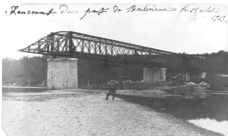
le 18 octobre 1913, rive gauche : les piles n°10 et 11 et la culée rive gauche portant le pont de fer en cours de montage
